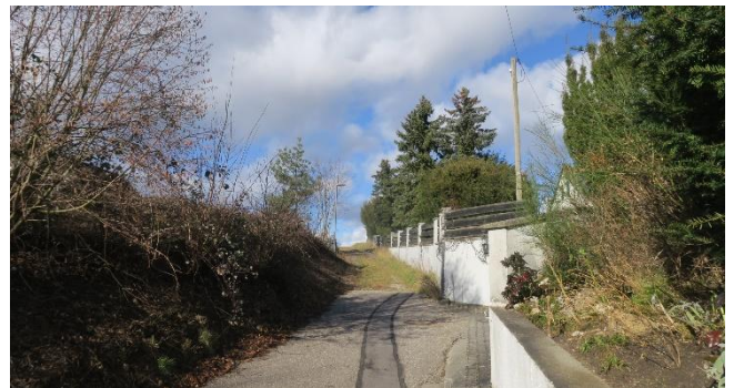
Straßenanschluss an die Straße „Am Hölzl“, Blick nach Norden
