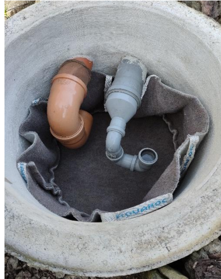
Filter für den Zulauf in die Zisterne: Die Anlage wurden 1994 in Eigenleistung eingerichtet und wird seitdem mit großer Zufriedenheit genutzt. Der Filter wird je nach Verschmutzung oder Starkregenereignisse 2 bis 3 Mal jährlich gereinigt. Foto: Manfred Röhner
