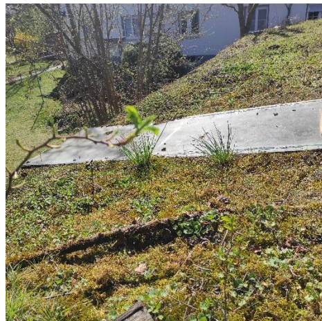
Praxisbeispiel eines in Eigenleistung installierten Gründachs: Für die Konstruktion wurden eine Teichplane, beschwerende Steine und Erde verwendet. Die Begrünung wurde der natürlichen Entwicklung überlassen. Fotos: Sabine Rhein.
