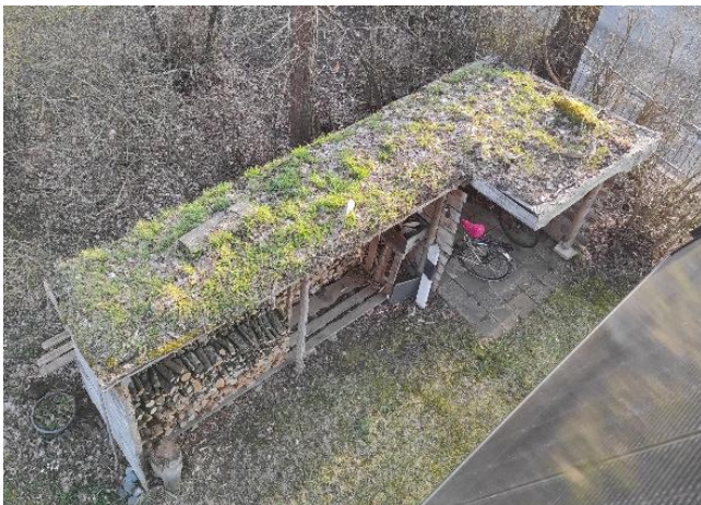
Praxisbeispiel eines in Eigenleistung installierten Gründachs: Für die Konstruktion wurden eine Teichplane, beschwerende Steine und Erde verwendet. Die Begrünung wurde der natürlichen Entwicklung überlassen. Fotos: Sabine Rhein.
