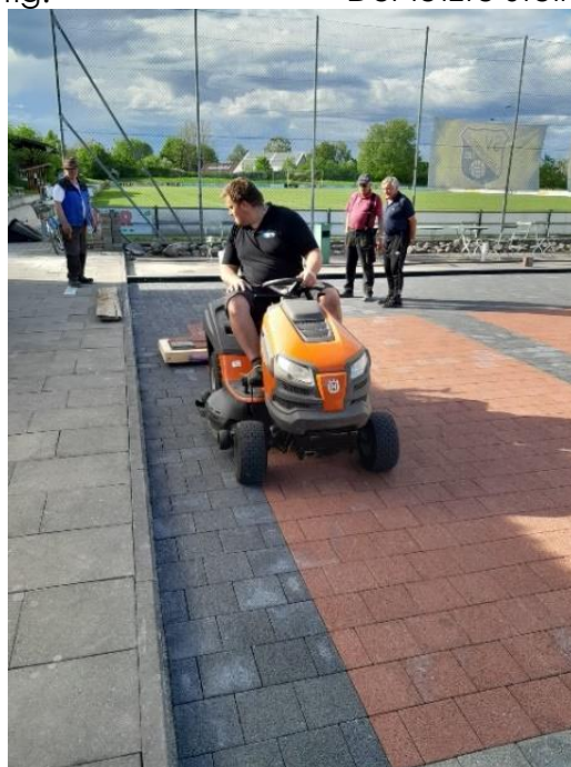
Den neuen Pflasterbelag abschleifen.
