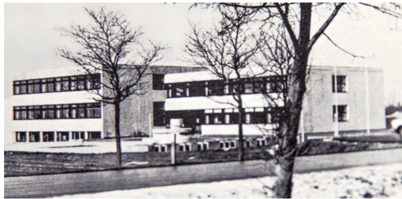
Zentralschulhaus Oberding im Jahr der Errichtung (1972)
