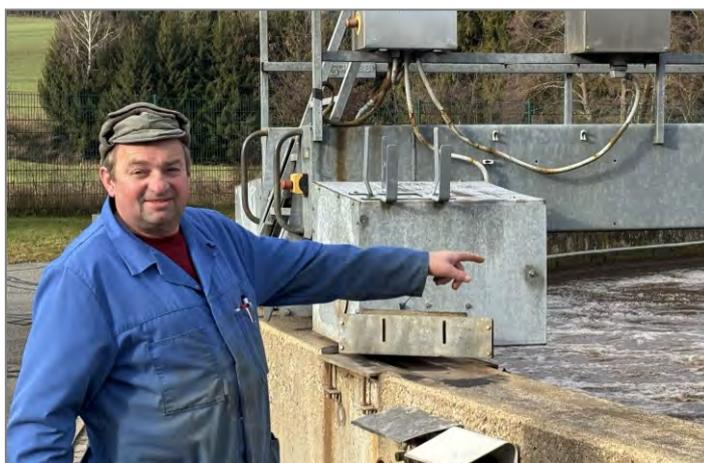
Flüssigkeiten, die unter anderem beispielsweise bei der Verarbeitung von Fleisch- und Wurstwaren entstehen, durch einen Fett- oder Ölabscheider geleitet werden (müssen!). Dieser muss regelmäßig gereinigt sein, um die Funktionstüchtigkeit zu erhalten.
