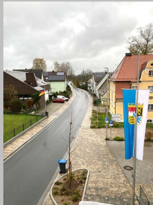
Ausbau Kreisstraße FO 13
