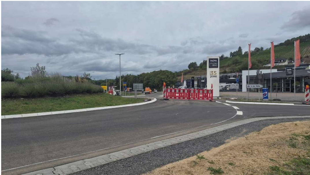
Fertiggestellte Strecke zwischen Marktheidenfeld und Erlenbach -1_BR StBA Wü © Staatliches Bauamt Würzburg, H. Grötsch
