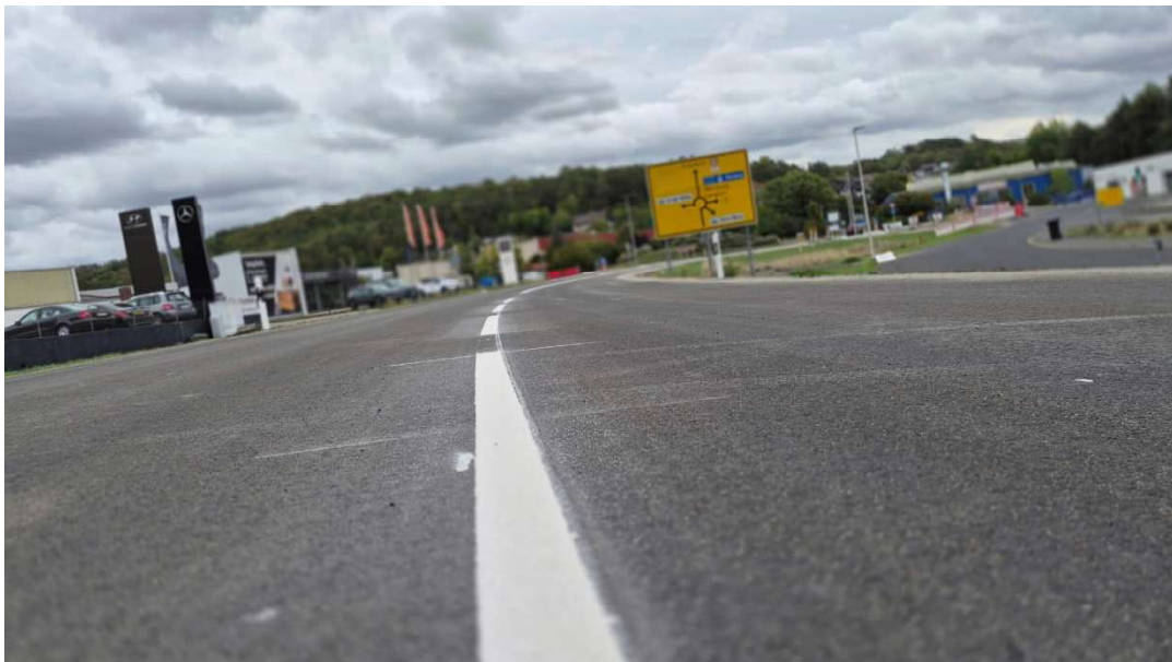
Fertiggestellte Strecke zwischen Marktheidenfeld und Erlenbach - 2_BR StBA Wü © Staatliches Bauamt Würzburg, H. Grötsch
