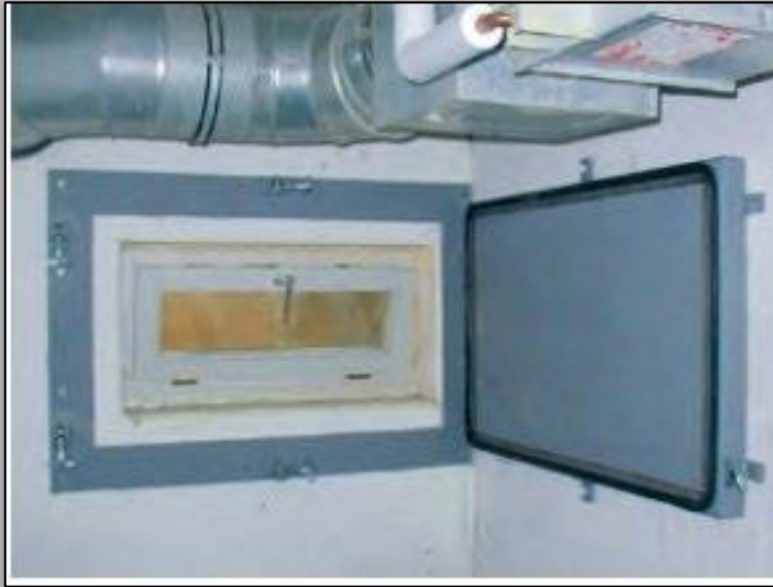
Druckdichtes, selbstschließendes Fenster (BMUB, 2016)
