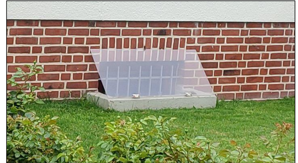
Schutz des Lichtschachtes (hamburg.de, S. Hellmers)
