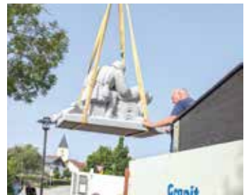
Am Freitag, den 28.08.2026 wurde das Denkmal zurück an seinen ursprünglichen Platz gehoben.
