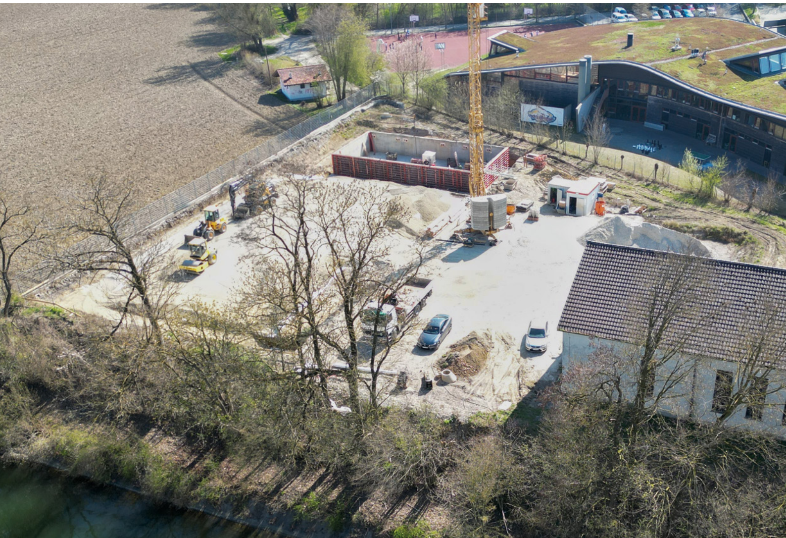
Baustelle des neuen Bauhofs in Aufkirchen
