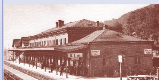
Empfangsgebäude des Bahnhofs Elm (1873-1945)
