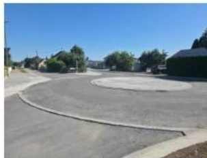
Sanierung der Straße „Am Schlossberg“. Mit Natursteinmauer im Bereich des Einschnittes und Kreisel in der Einmündung Vohburger Straße (Ost). Ab Mitte September wird weiter asphaltiert werden.
