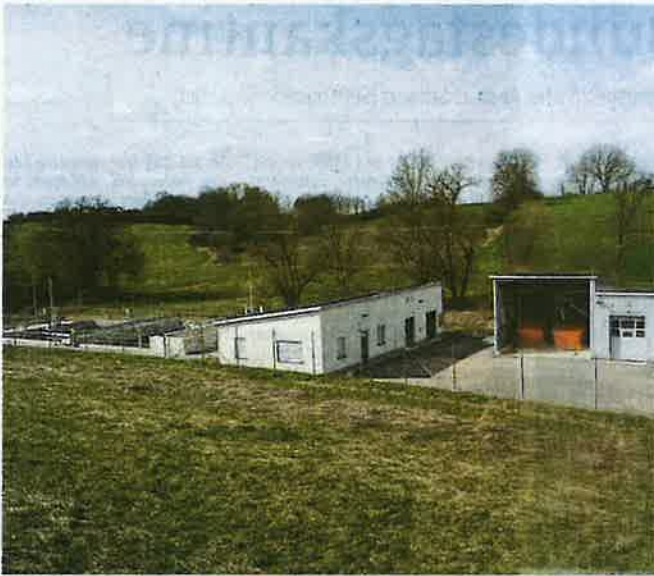
Weil für die Teichkläranlagen in der Gemeinde Höttingen die wasserrechtliche Erlaubnis abgelaufen war, entstand eine zentrale Kläranlage bei Weiboldshausen. Foto: Hans Seibold
