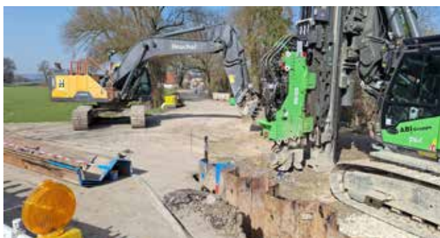
Baustelle Bertoldsheim (Pumpstation und Abwasserüberleitung)
