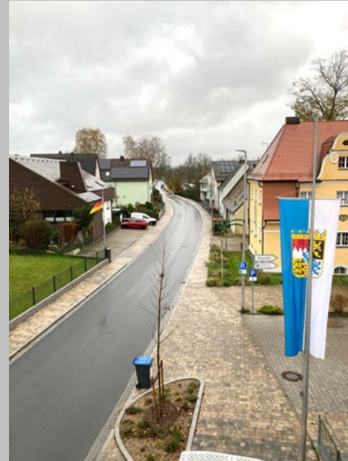
Ausbau Kreisstraße FO 13
