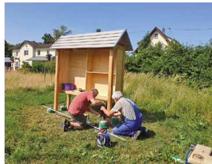
Der Rohbau des Bienenhotels wird in der Nähe des Schul-Ackers aufgebaut.
