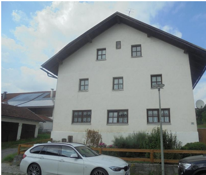
Copyright: Dr. Klaus Bauer, Sanierung ehem. Bauernhaus, vorher
