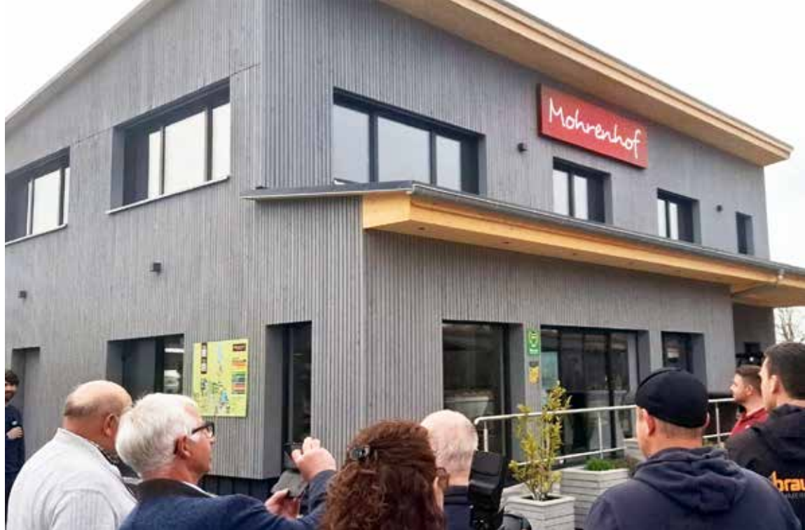
Das neue Verwaltungsgebäude.
