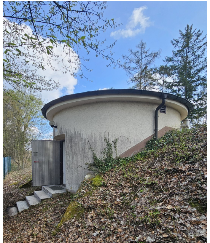
Bild: Hochbehälter Eckertsberg
