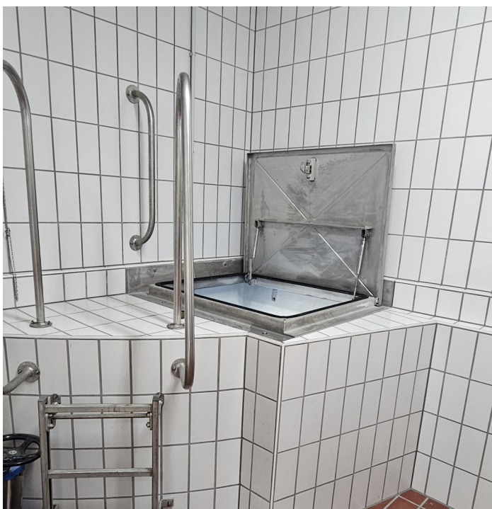
Bild: Hochbehälter Artelshofen
